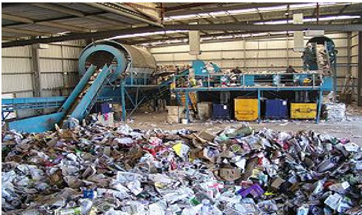
FIGURA 5-6 IMPIANTO DI SEPARAZIONE A FREDDO DELLA FRAZIONE SECCA PER L'ULTERIORE RECUPERO DI MATERIALI DA RICICLARE.
