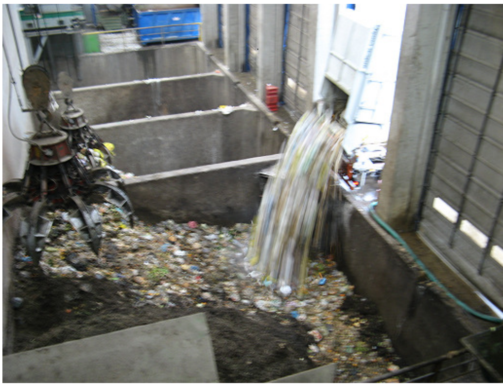
FIGURA 7-1 BASSANO DEL GRAPPA (VICENZA): FOSSA PER LA RICEZIONE DEI RIFIUTI ORGANICI DA RD E IL SUCCESSIVO TRATTAMENTO IN IMPIANTO DI DIGESTIONE ANAEROBICA
