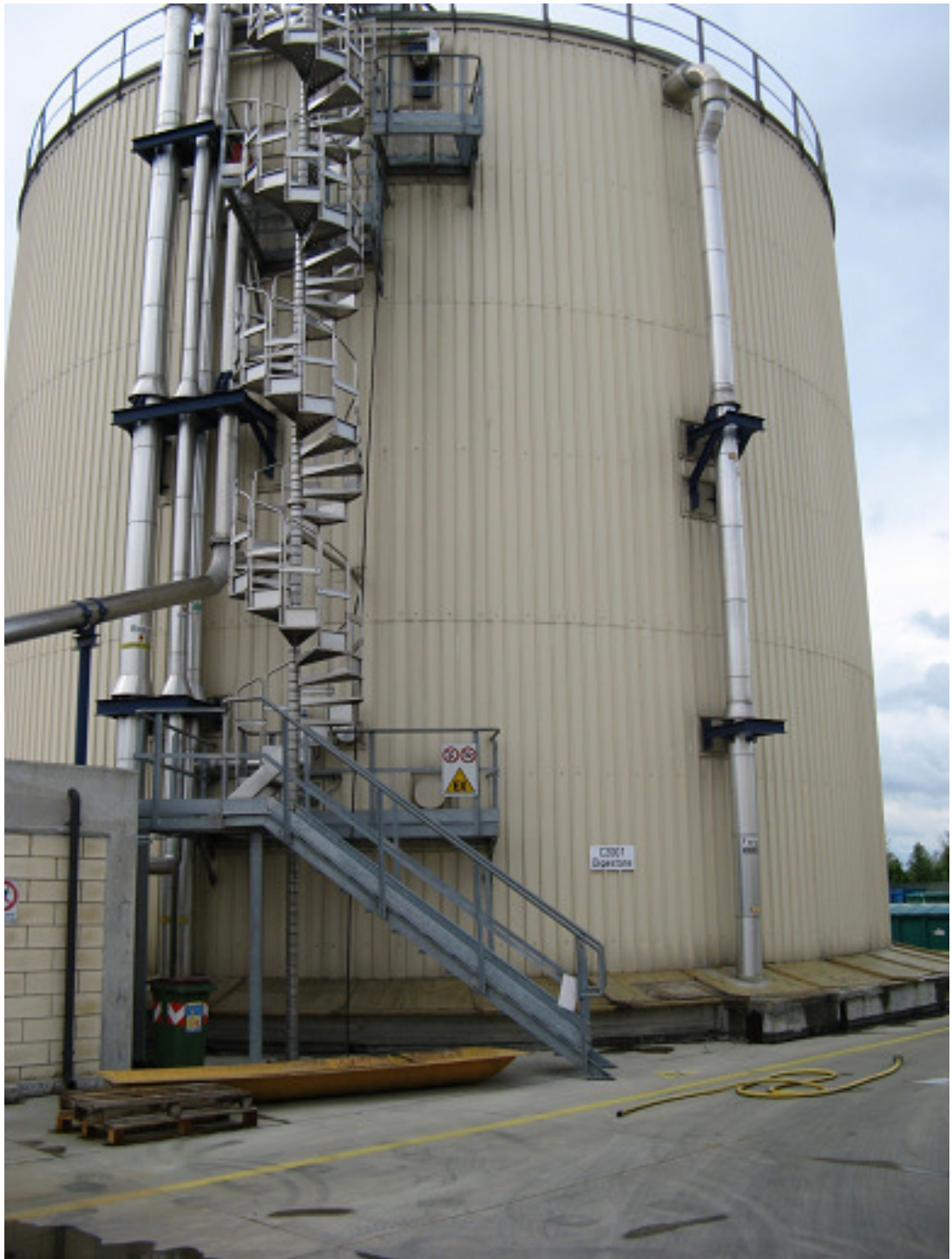
FIGURA 7-2 CAMPOSAMPIERO (PADOVA): DIGESTORE ANAEROBICO PER RIFIUTI ORGANICI DA RD REALIZZATO NEI PRESSI DI IMPIANTO PER IL TRATTAMENTO DELLE ACQUE REFLUE
