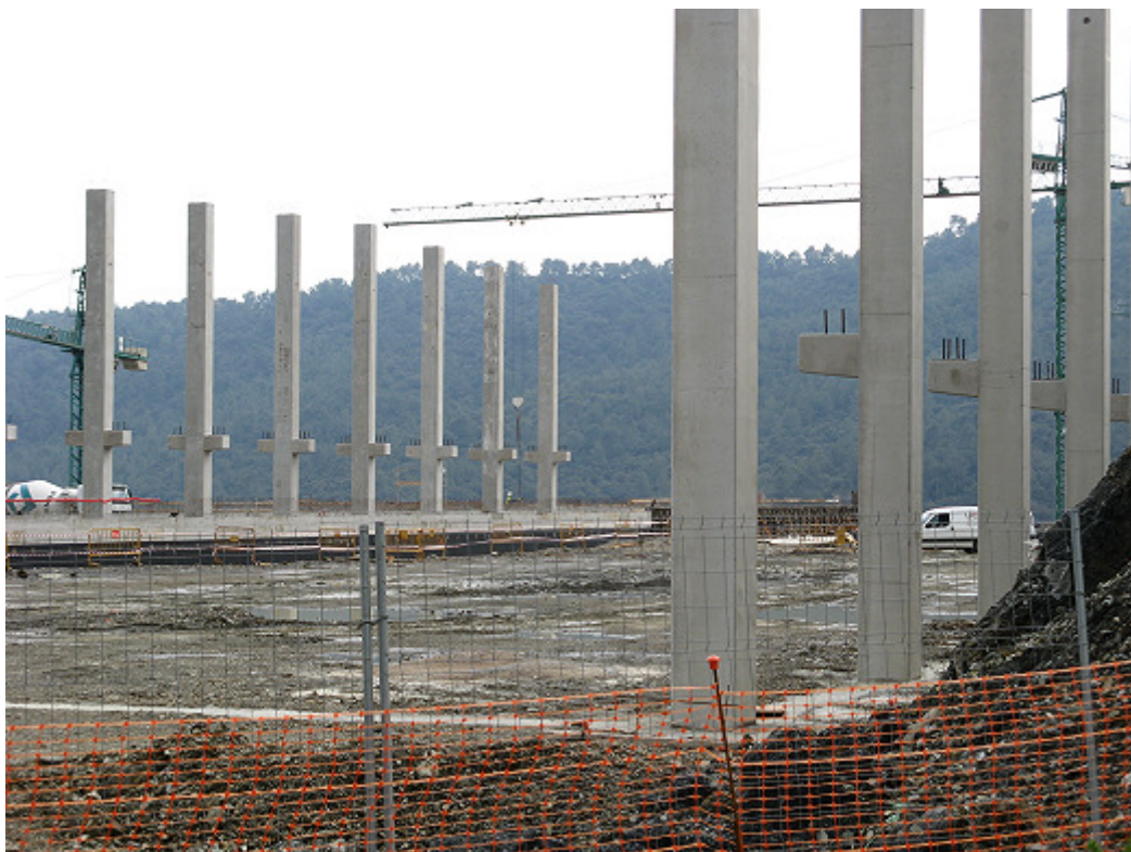
FIGURA 5-17CASTELLGALÌ CATALUNYA SPAGNA: LAVORI IN CORSO PER LA COTRUZIONE DELLA SEZIONE DI PRETRATTAMENTO DEI RIFIUTI FINALIZZATA AL SUCCESSIVO TRATTAMENTO DEI RESIDUO CON TORCIA AL PLASMA
