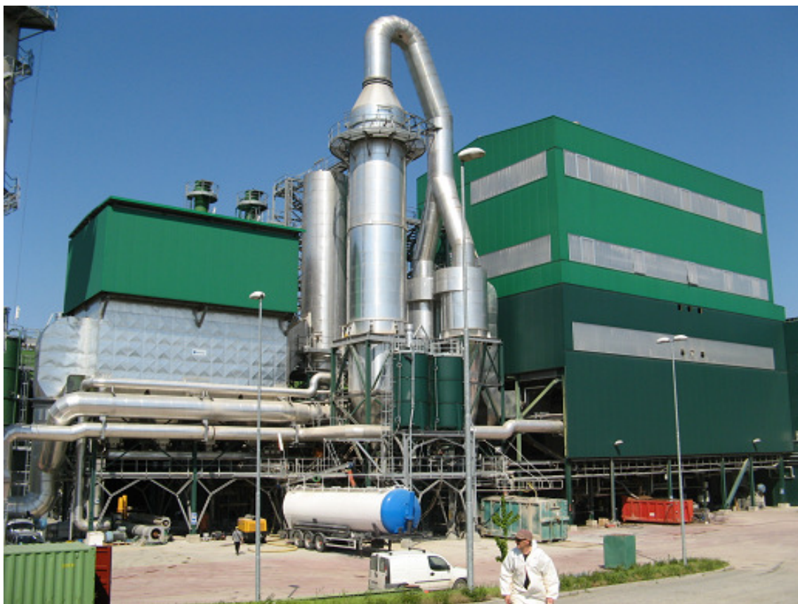
FIGURA 5-11 CORTEOLONA (PAVIA): IMPIANTO A LETTO FLUIDO
