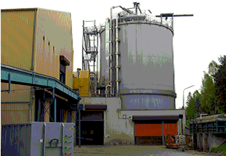
5-5 KAISERSLAUTERN: DIGESTORE ANAEROBICO PER IL TRATTAMENTO DELLA FRAZIONE UMIDA DERIVANTE DA SEPARAZIONE DEGLI INDIFFERENZIATI
